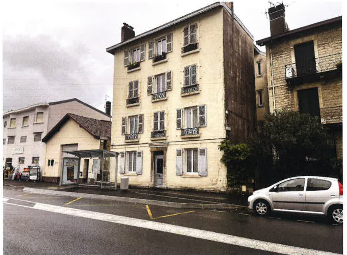
DP 8 : PHOTOGRAPHIE ENVIRONNEMENT LOINTAIN
